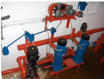
Nuværende borerørpumper.
