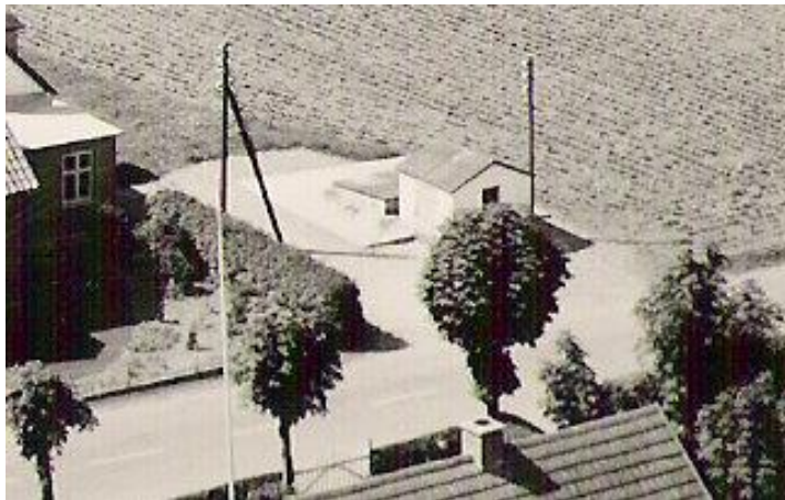
Det gamle vandværk (pumpehus og brønd).
