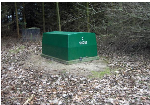
Overdækning af boring i Vang Jarls have.
