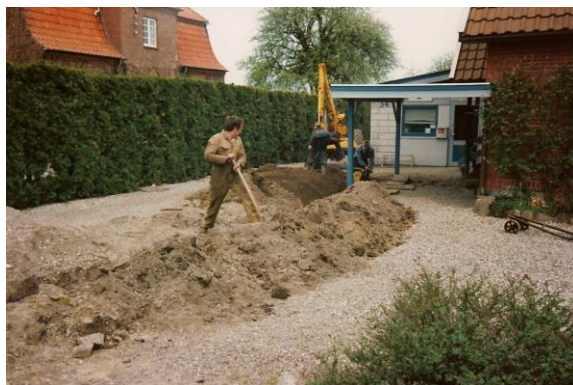
Udbedring af stikledning til Jullerupvej 54.
