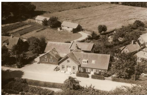
Tømrerværkstedet (nu) Jullerupvej 26.
