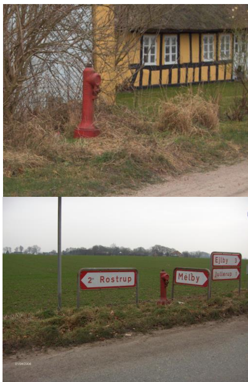
I forbindelse med den ny rørledning blev der monteret brandhaner flere steder.
